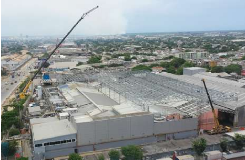
Interventoria cambio cubiertas planta Barranquilla- Coca Cola Femsa
